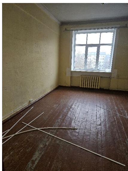
Trešā stāva dienesta viesnīcas telpas
