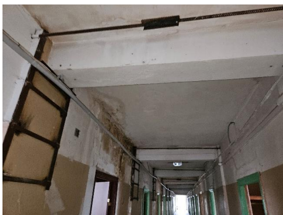
Trešā stāva dienesta viesnīcas telpas
