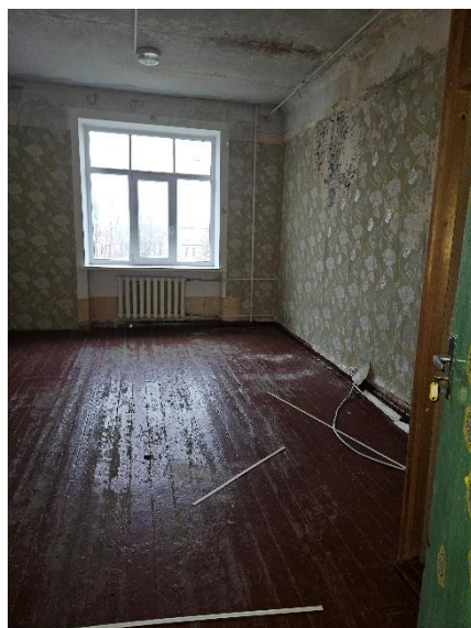
Trešā stāva dienesta viesnīcas telpas
