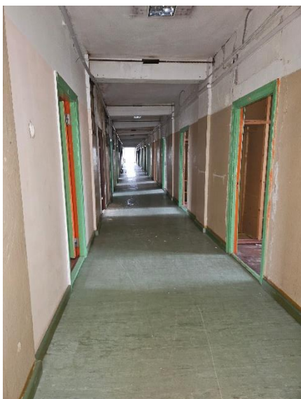
Trešā stāva dienesta viesnīcas telpas
